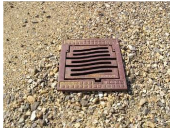
Karmen med rist/dæksel placeres i beton topningen eller opføringsrøret og lægges løst i vej materialet.
