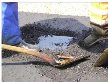
Karmen løftes op, så der kan komme asfalt ind under karmen. Asfalten pakkes godt ind under hele flangen.
