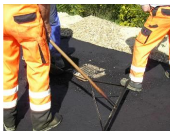
Det er meget vigtigt, at være omhyggelig så hele hulrummet under flangen er pakket med asfalt
