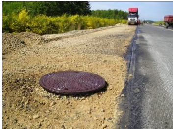
Vejmaterialet omkring brønden / opføringsrøret komprimeres godt.
