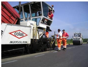
Asfalten udlægges i den dimensionerede tykkelse.
