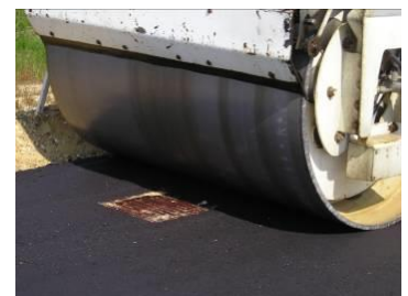
Karmen tromles ned i niveau. Anlægsfladen og åbningshuller rengøres før brønden forlades.
