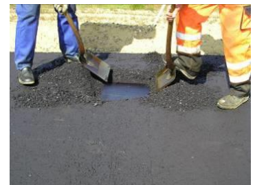
Asfalten fjernes helt fra dæksel/rist og karm.
