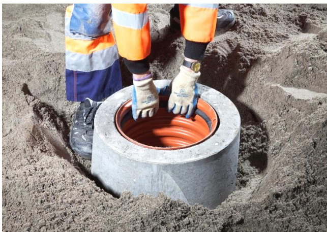
Cellegummiringen monteres i opføringsrøret.
