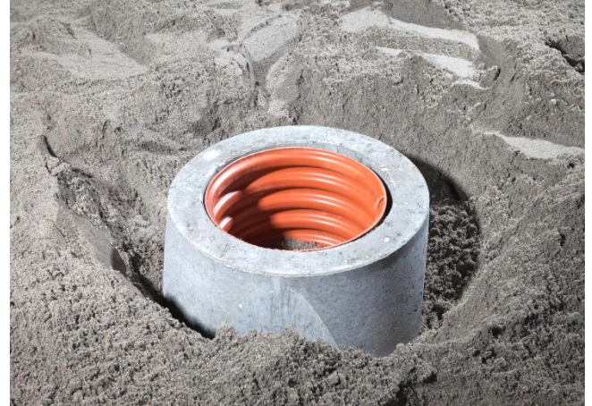
Beton kegle sættes ned over opføringsrøret.
