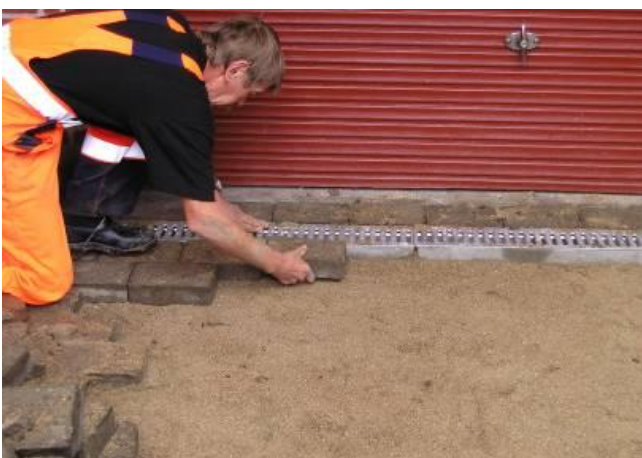
Belægningstenene lægges igen. Ristene lægges i.
