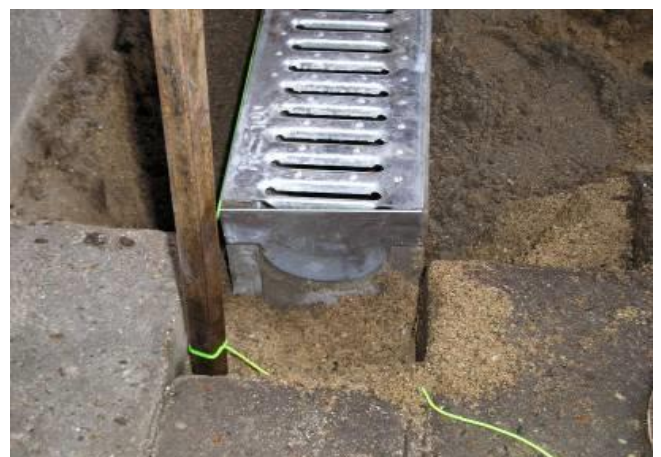
Rendeelementerne placeres efter hinanden, ende-vægge monteres.
