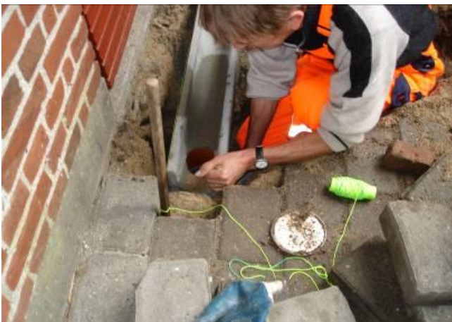
Beton lægges i, start med renden med hul i. Monter så afløb.
