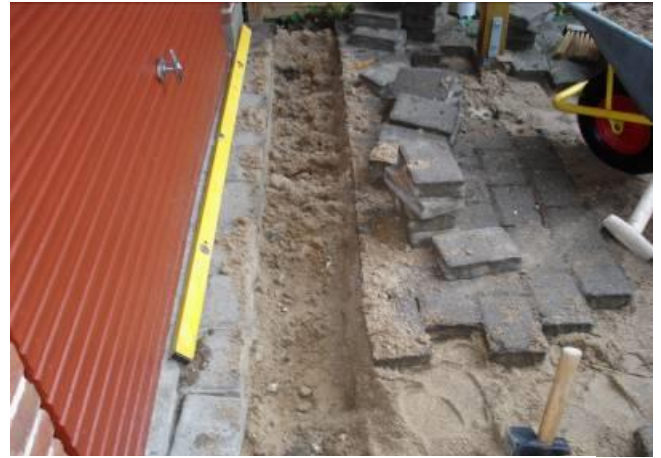
Belægningssten fjernes, afløbsrør monteres.
