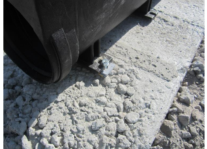
HYDROblocken kan via fødderne fæstnes til det underliggende betonfundament.
