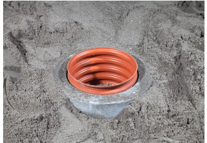
Keglen sættes ned over opføringsrøret.
