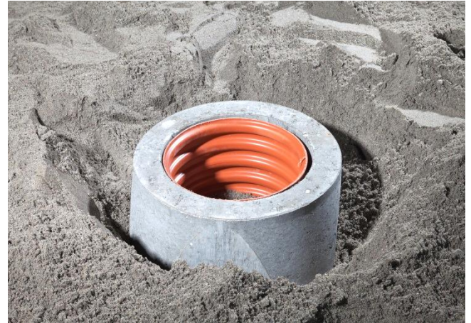
Keglen sættes ned over opføringsrøret.
