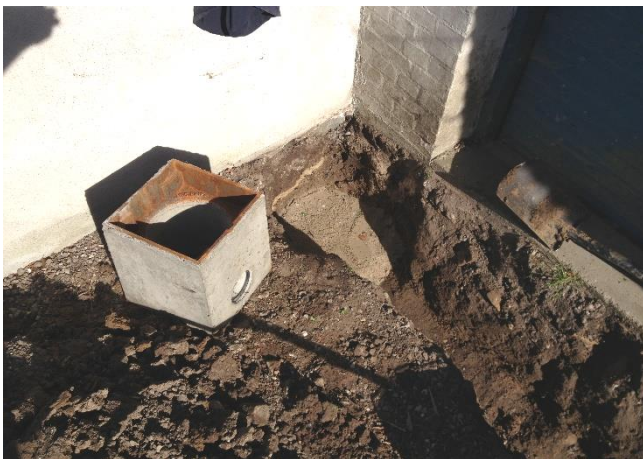
Kom grus i bunden af hullet til tørbrønden.
