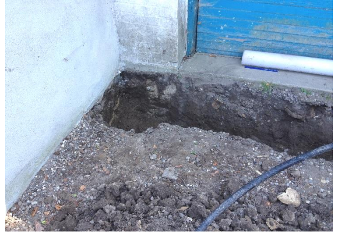
Der graves ud til tørbrønd og afløbsrør.
