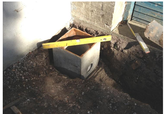
Tørbrønden placeres i gruset og nivelleres så brønden står i vater.
