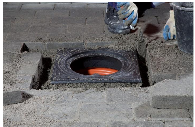
Den overskydende beton fjernes.
