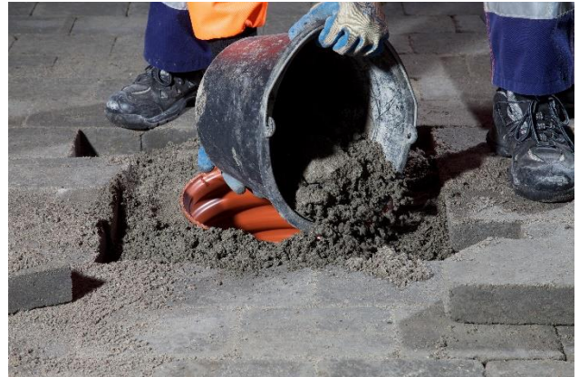
Beton dæksel og belægningsstenene fjernes. Der lægges beton rundt om opføringsrøret.
