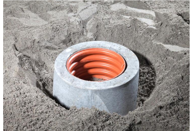
Kegle sættes ned over opføringsrøret.
